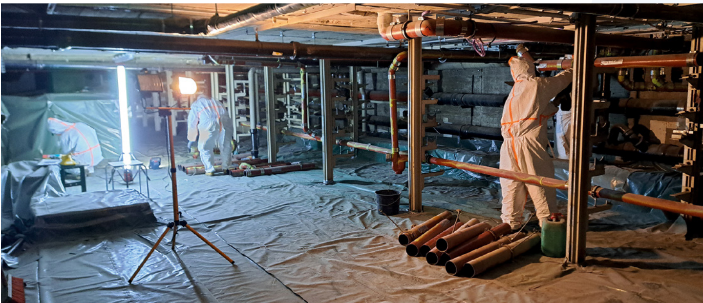
Logistisch anspruchsvoll war der Rückbau des weit verzweigten, möglicherweise kontaminierten Netzes an Lüftungs- und Abwasserleitungen. Die betroffenen Bereiche wurden als Interimskontrollbereich deklariert, entsprechend abgegrenzt und unter erweiterten Strahlenschutzmaßnahmen betrieben.
