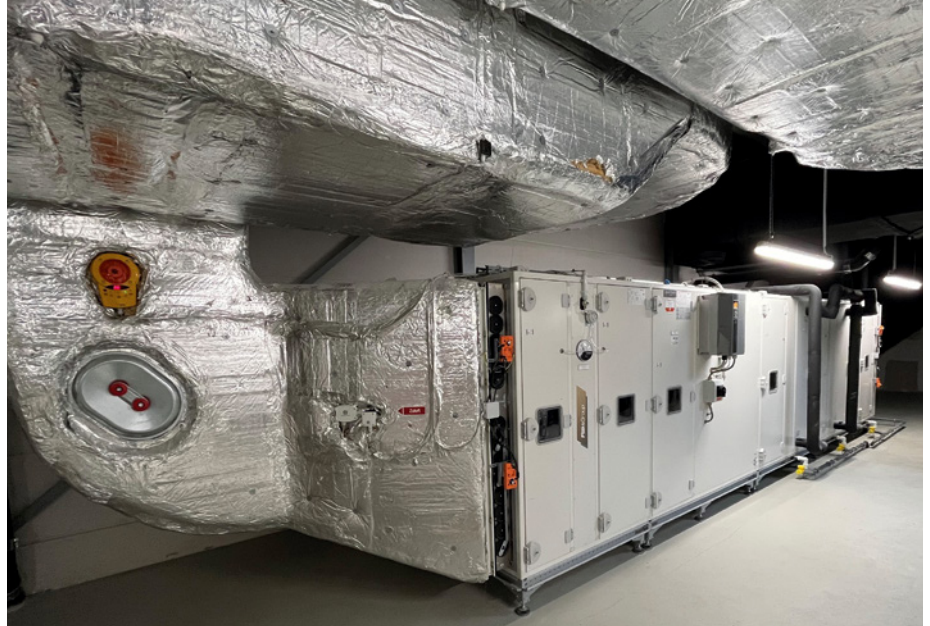
Mit Contracting können die im Transformationsplan identifizierten Energieeffizienz- und Dekarbonisierungsmaßnahmen wirtschaftlich realisiert werden.
