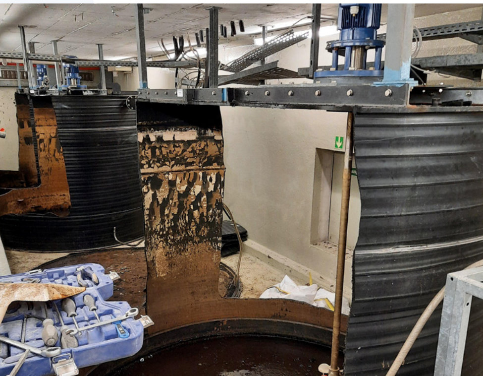
Aufgrund der beengten Verhältnisse und der notwendigen Schutzmaßnahmen zur Kontaminationskontrolle war der Rückbau der nuklearmedizinischen Abwasserbehandlung und der Abklingbehälter besonders herausfordernd.
